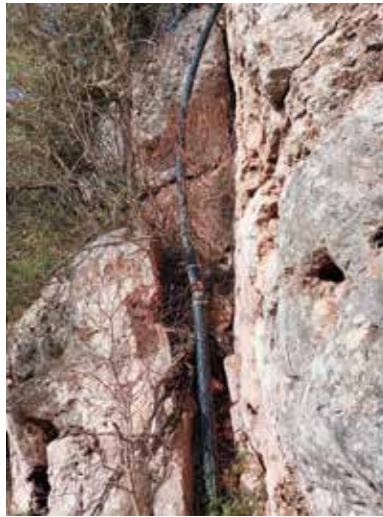
Tub de l'abocament de la depuradora des Migjorn Gran a Son Boter al qual aporta molts nitrats i enterococs.
